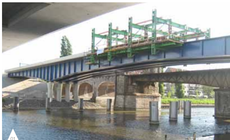
01 Waggelwaterbrug, Brugge, België
