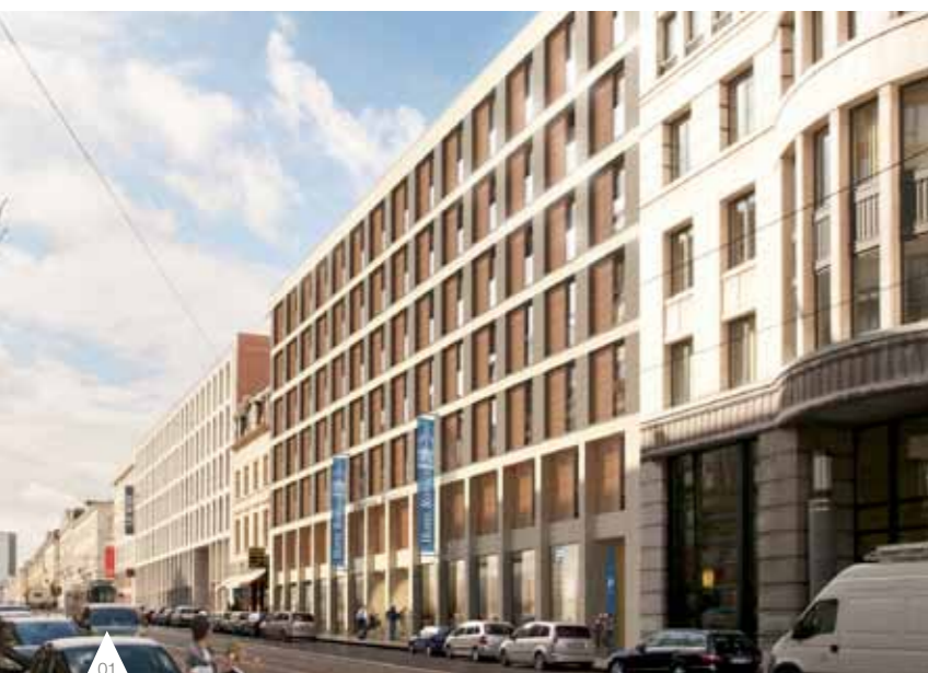
01 Motel One, Brussel, België, Architect: SM Archi 2001
